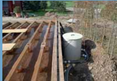
Tauchpumpenschacht
